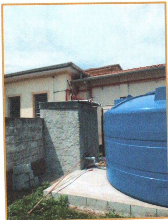
Casa de Bombas - Caixa D'Água Instalada
