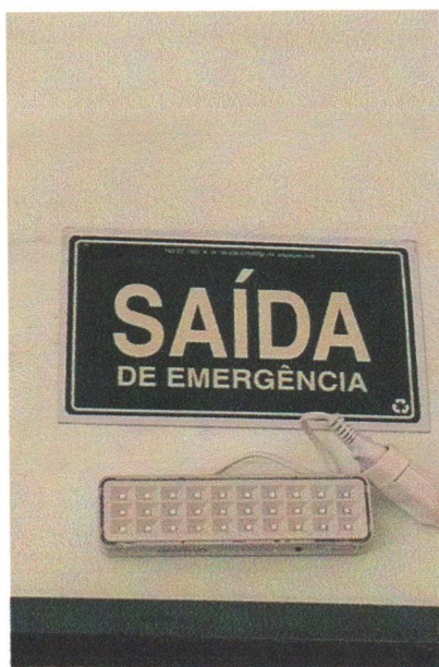
Finalização da instalação de sinalização de rota de fuga e equipamentos
