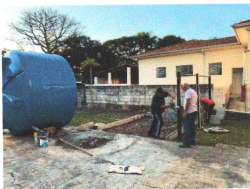
Preparando as Tubulações
