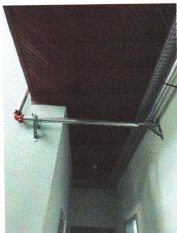
Caminho do hidrante da creche piso superior
