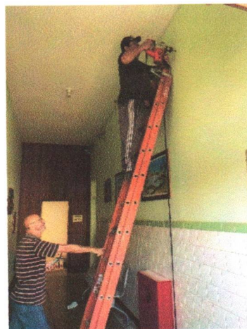
Colocação das Tubulações
